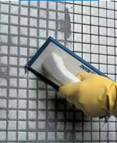
Rejuntado de revestimientos de mosaico vítreo (en baño) con llana
