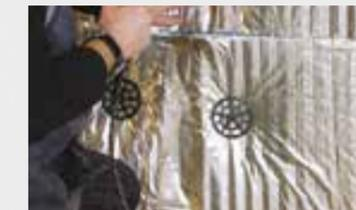
Caso particular: en caso de instalar el HYBRIS en un cerramiento con una altura  $> 2,65\text{m}$ , fijar una primera fila de paneles y mantenerlos mediante 2 espigas plásticas fijadas en la parte alta del panel. Seguidamente, fijar la segunda fila de paneles en vertical sobre la primera, manteniéndolos mediante 4 espigas por panel.
