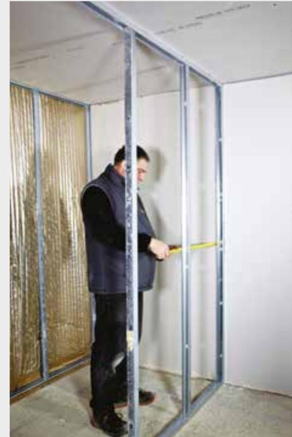
1 Colocar la estructura metálica de acuerdo con las normas vigentes y especificaciones del fabricante.
