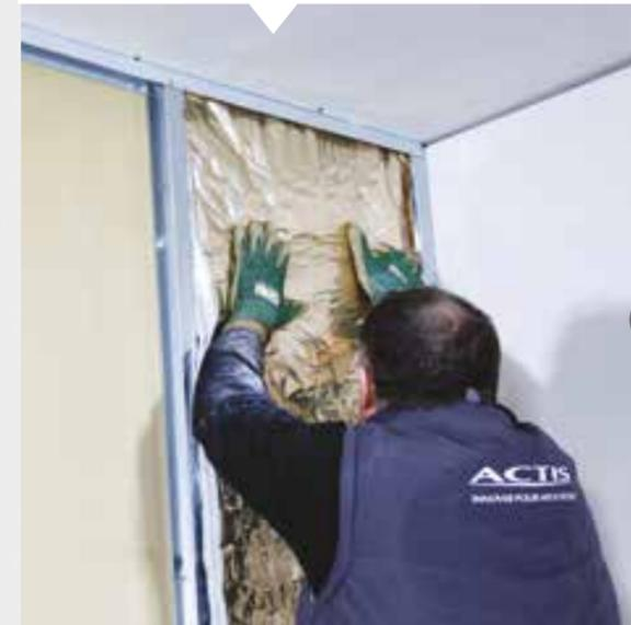
5 La colocación de los paneles se realiza con los alvéolos en horizontal. Cortar los paquetes HYBRIS sin abrir según la distancia entre ejes de los montantes incrementada en 0,5cm. Abrir los paquetes y colocar el primer panel entre los montantes con los alvéolos en horizontal empezando por arriba. Colocar el resto de paneles de la misma manera. Cortar el último panel a medida para terminar de rellenar el hueco.
