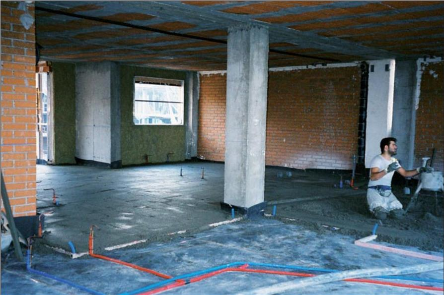
**Fotografía 2.** Colocación con calefacción por encima de la lámina IMPACTODAN.
