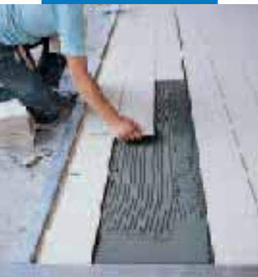
Colocación mármol Jura con Granirapid blanco
