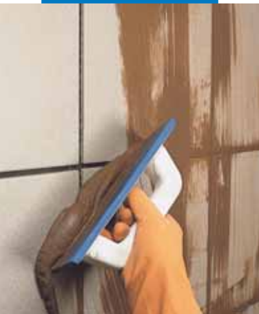
Rejuntado de revestimiento externo con llana
