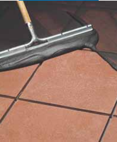
Rejuntado de pavimento de terracota con rasqueta
