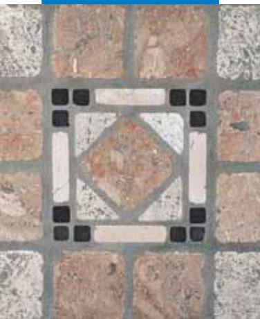
Ejemplo de rejuntable de pavimento antiguo de piedra natural
