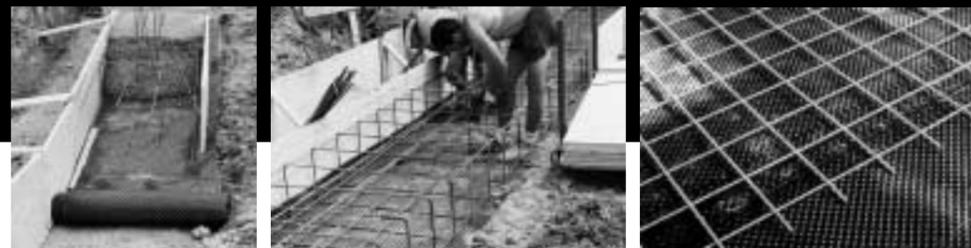
DRENTEX PROTECT en soleras acelera y economiza la aplicación de hormigón.
