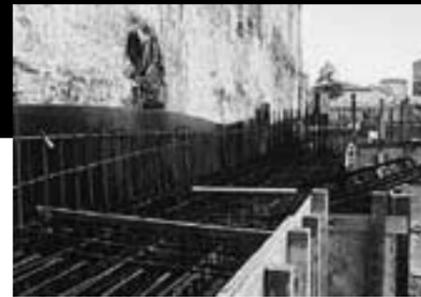
DRENTEX PROTECT PLUS colocado como protección de un edificio próximo a una pared con humedad.
