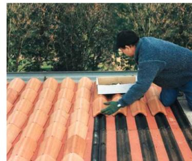
Colocación de Texsaplack BT canal sobre solera.
