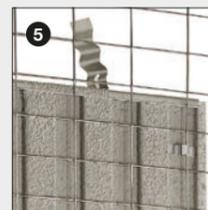
5 Red metálica y clips de fijación
