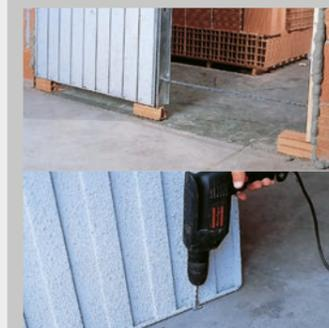
5a. Fijación sobre pavimento por terminar.
