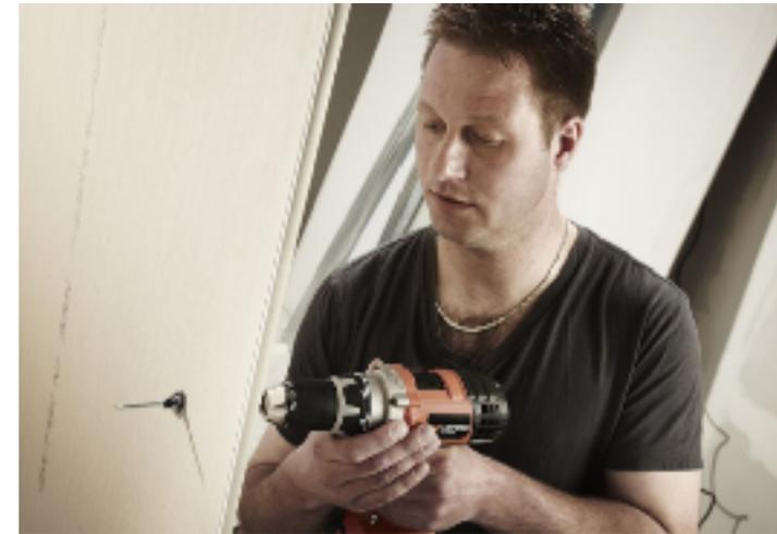
**Para cargas más pesadas**, lo ideal es utilizar fijaciones metálicas que se retraigan tipo paraguas, para garantizar la carga máxima de la placa de yeso. Debemos elegir un taco que sea válido para todos los tipos de tabiques, ya tengan una placa, dos placas o tres placas.
